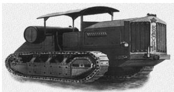
В 1923 году на Харьковском заводе приступили к выпуску гусеничных тракторов «Коммунар» с двигателем мощностью 36,8 кВт, трёхскоростной коробкой передач, скоростью от 1,8 до 7 км/час.
